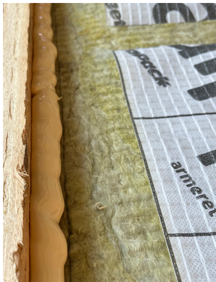
alpha Folieklæber fugetykkelse Ø 20 mm.
