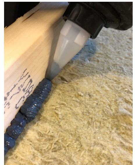
AEROSANA VISCONN Kanten fuges så der dannes hulkel.
